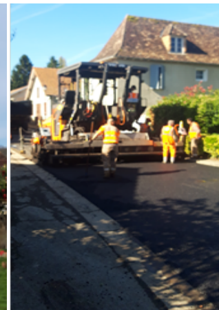
Travaux de voirie
