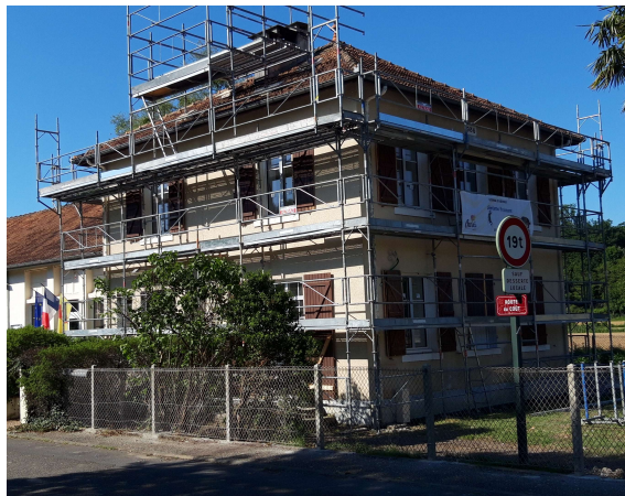
Rénovation du logement communal
